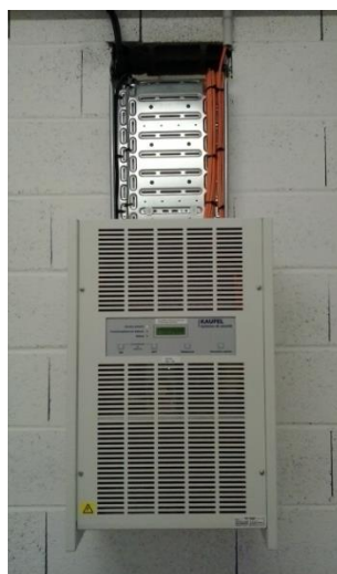
TGBT et Tableau Sources 48V pour balisage
