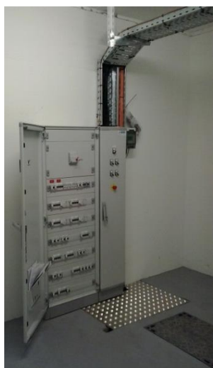
TGBT et Tableau Sources 48V pour balisage
